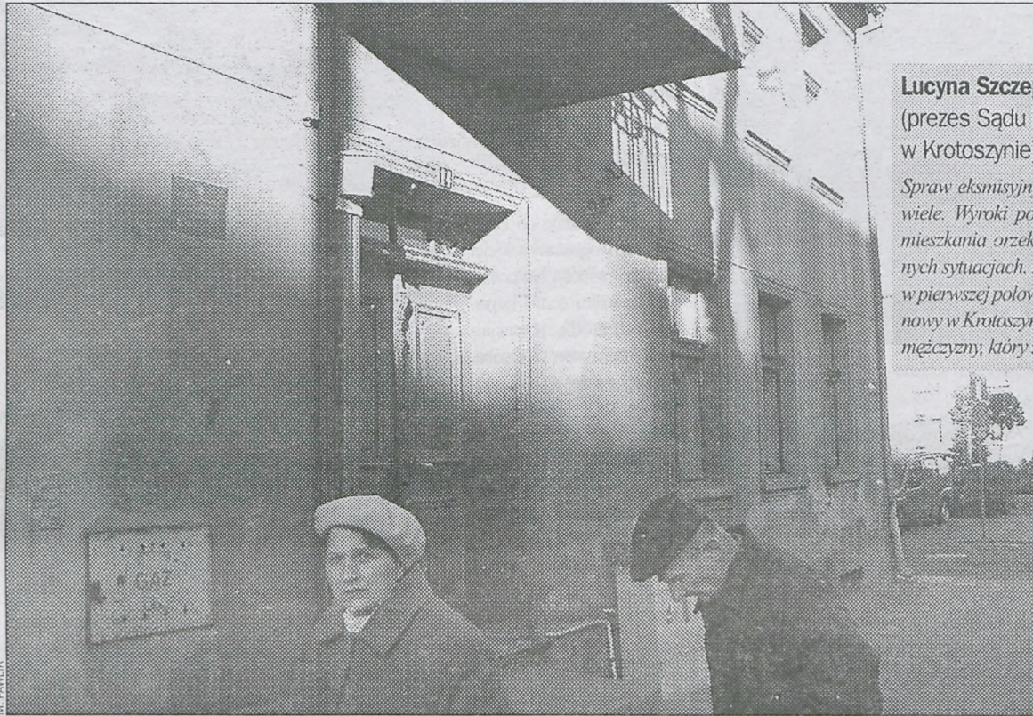
Czasem eksmisja jest konieczna ze względu na zły stan budynków
