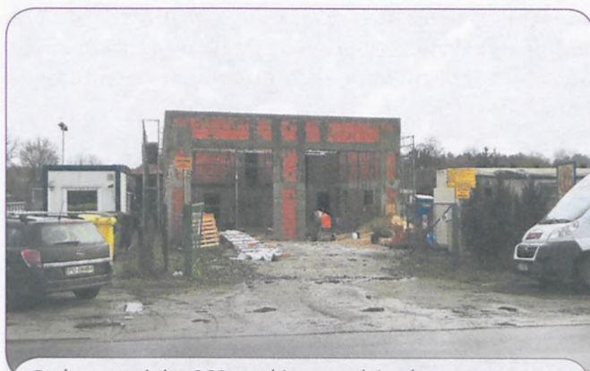
Budowa strażnicy OSP przebiega zgodnie z harmonogramem.
