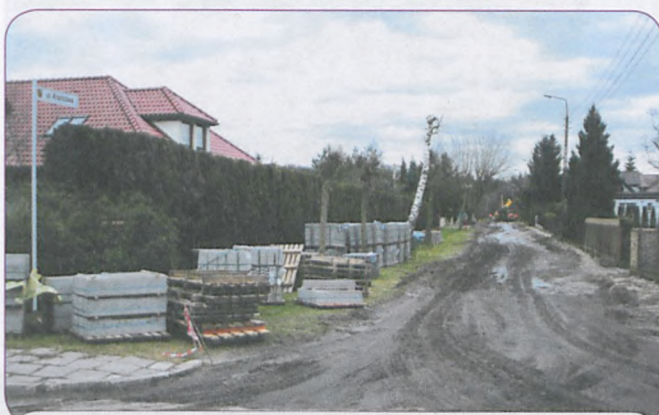
Na ul. Krańcowej rozpoczęły się już prace.
