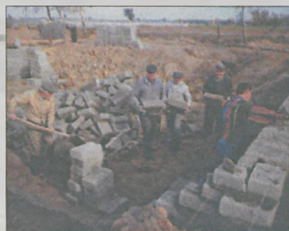
Budowa zjednoczyła wieś – str. 9
