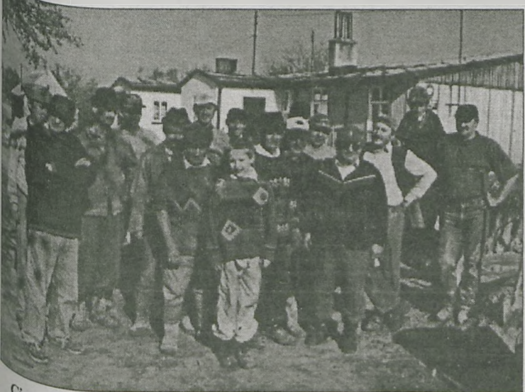
Ci mężczyźni pracowali przy wylewaniu ław fundamentowych
