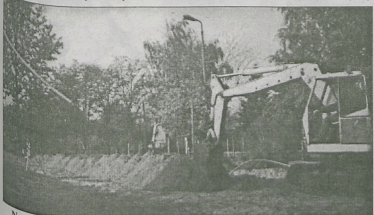
Na budowie oczyszczalni w Kaczkach
