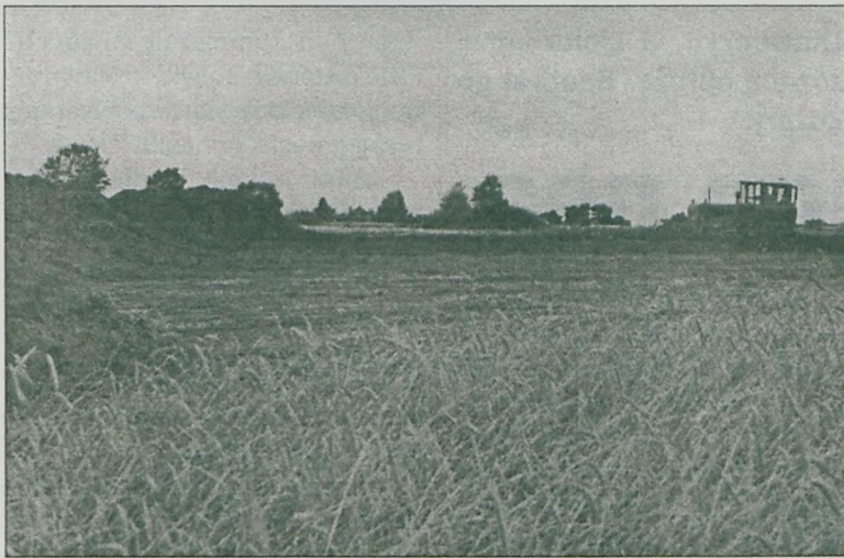
„Rozpoczęto pierwsze prace ziemne przy budowie autostrady
