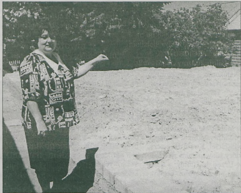
Dyrektor Aleksandra Popielarz na placu budowy
