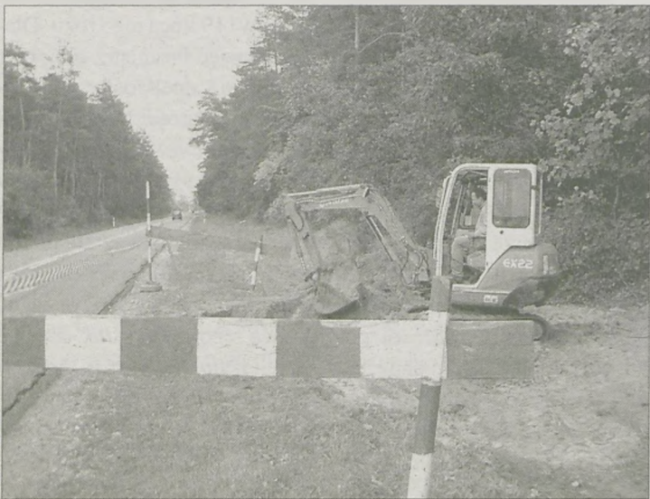
W GMINIE JARACZEWO zakończył się kolejny etap budowy kanalizacji
