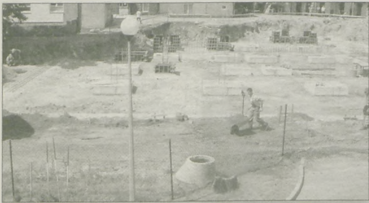
ZALANO ŁAWY FUNDAMENTOWE pod nowy budynek jarocińskiego szpitala
