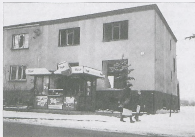
Dom do rozbioru przy ul. Poniatowskiego – miejsce ćwiczeń strażaków
