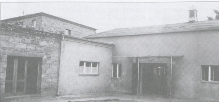
Widok kaplicy od strony podwórza. Widoczna przybudówka, która służyła jako zakrystia i salka katechetyczna.
