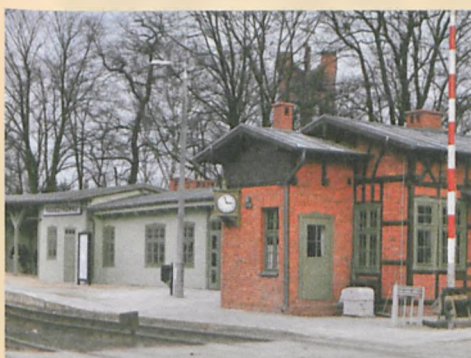
Budynek zabytkowego dworca po modernizacji, 2010
