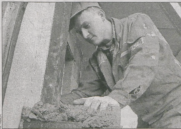
Remont potrwa do 10 grudnia
