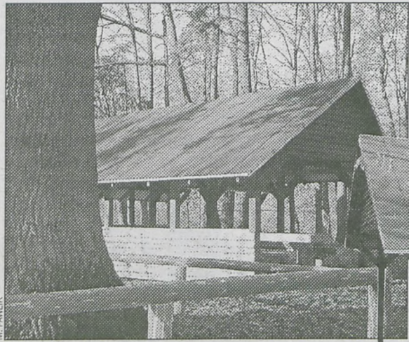
Budowa trwała zaledwie 2 tygodnie
