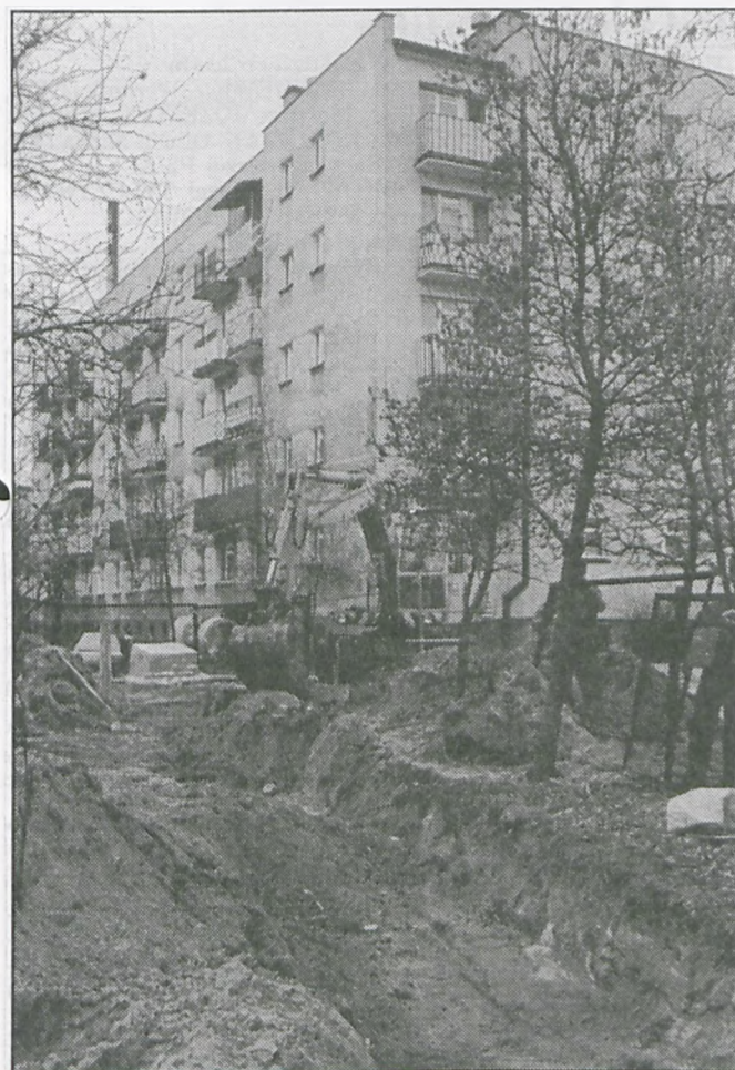
Kiedy w latach 60. budowano Osiedle Lubonia, ścieki z bloków skierowano do oczyszczalni typu "Inhoff", rurą Ø 250. Czas pokazał, że jest to zbyt mały przekrój, żeby sprostać zadaniu. Aktualnie buduje się fragment sieci kanalizacyjnej o przekroju 300, kierując ścieki z osiedla do kolektora w ulicy Targowej. Tę inwestycję wzorowo realizuje przedsiębiorstwo "Hydrobudowa 7".
