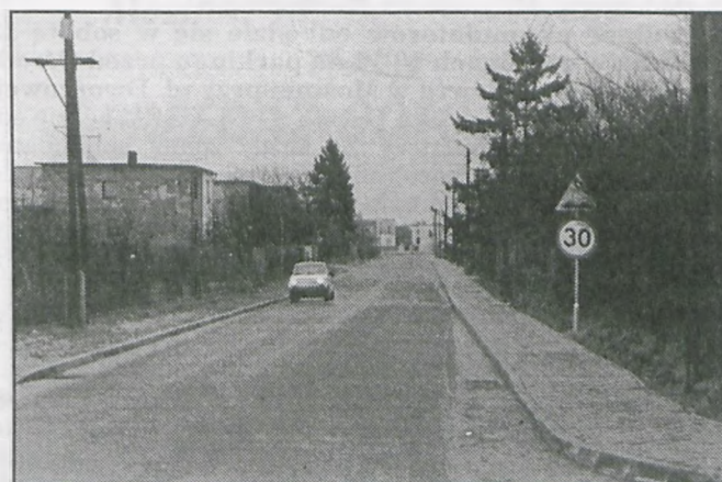
Przybywa porządnym nawierzchni. Odcinek ulicy Topolowej, od Piaskowej do Skrajnej, otrzymał jednostronny chodnik i utwardzoną jezdnię z trzema progami zwalniającymi, które skutecznie dyscyplinują kierowców, co zwiększa bezpieczeństwo pieszych. Druga strona pobocza pozostała nieutwardzona, ponieważ jest przygotowana do realizacji sieci gazowej w niedługim terminie. Wykonanie tego odcinka ul. Topolowej kosztowało 300.000 zł.
