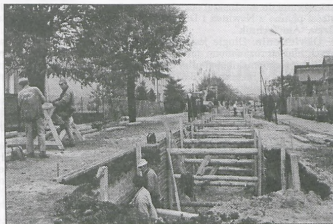
Kolektor sanitarny w ulicy Targowej zbliża się do przejazdu kolejowego. Ten ważny odcinek sieci kanalizacyjnej po przejściu pod torami kolejowymi otworzy drogę do skanalizowania śródmieścia i innych części miasta. Praca odbywa się bez zakłóceń, zgodnie z założeniami. Przyjęta metoda pozwala ułożyć kolektor bez wstrząsów, które poprzednio powodowały szkody w budynkach mieszkalnych.
