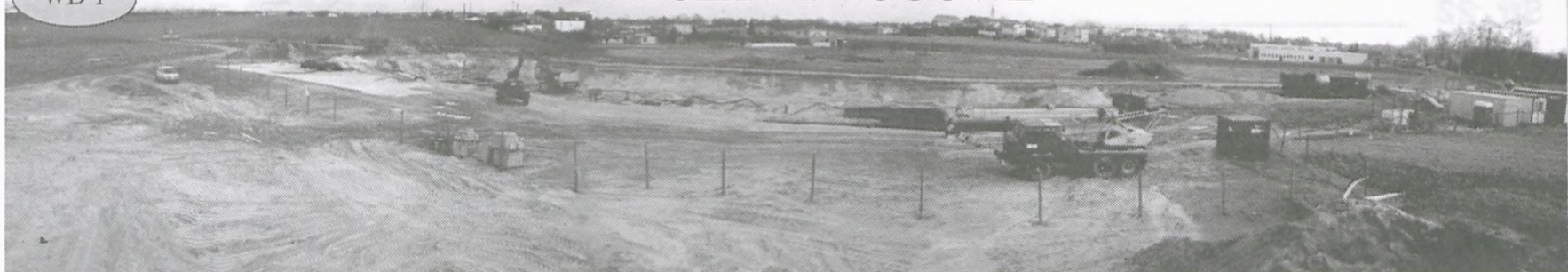
Na ul. Traugutta zaawansowane już prace nad budową wiaduktu, z tyłu objazd
