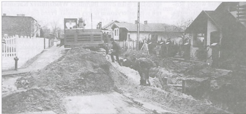
Budowa kanalizacji deszczowej wzdłuż ul. Walki Młodych
