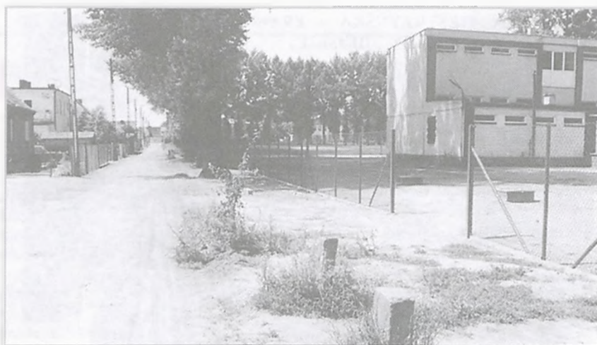
Postawienie nowego płotu przy Szkole Podstawowej nr 4 od strony ul. Dojazdowej zwiększyło szerokość drogi
