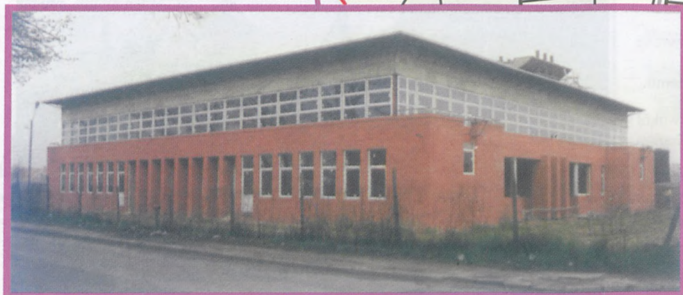
Szkoła Podstawowa nr 5 w budowie - fot. Sebastian Linkiewicz
