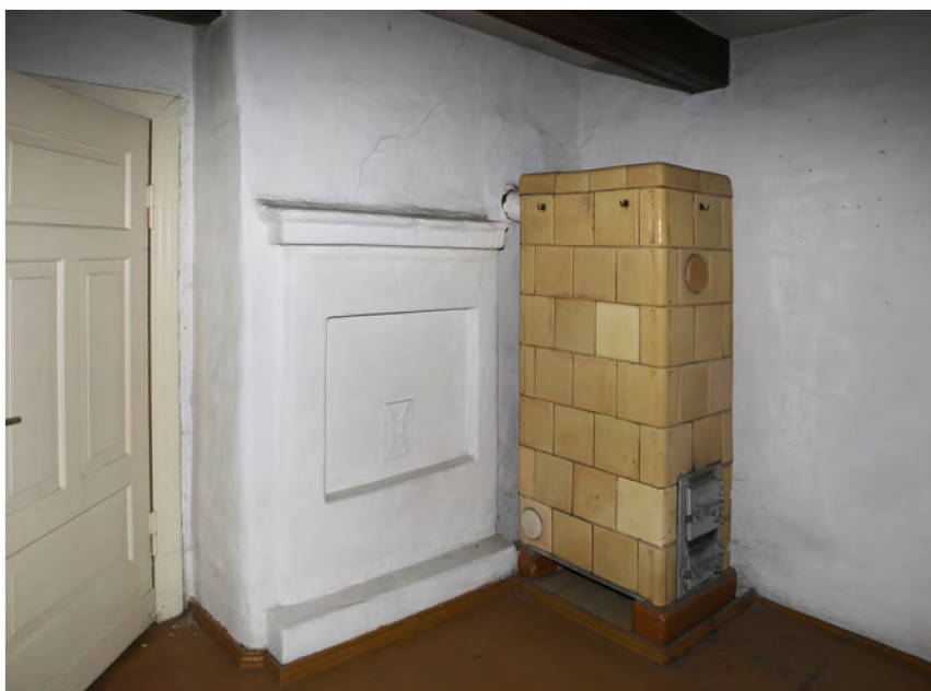
Il. 6 a-b. Strop i kominek w budynku narożnym – stan obecny. Fot. Zdzisław Nowakowski
