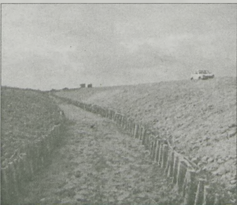
Rów odprowadzający wodę – fragment odbudowywanej rzeki Teleszyny
