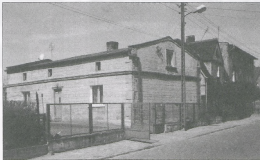
Widok ogólny domu Remleina w Luboniu przy ul. 3 Maja
