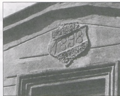
Starannie odnawiana ściana wschodnia (od ulicy) z napisem: datą otynkowania domu zbudowanego w 1866 r.
