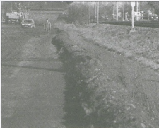
0,5-metrowy wał ziemi usypany wzdłuż ul. Dworcowej
