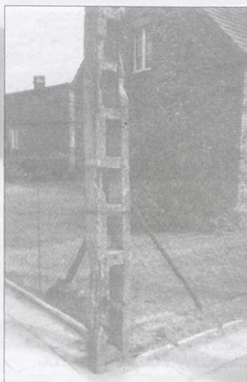
Żelbetonowy słup u zbiegu ulic Długiej i Poprzecznej
