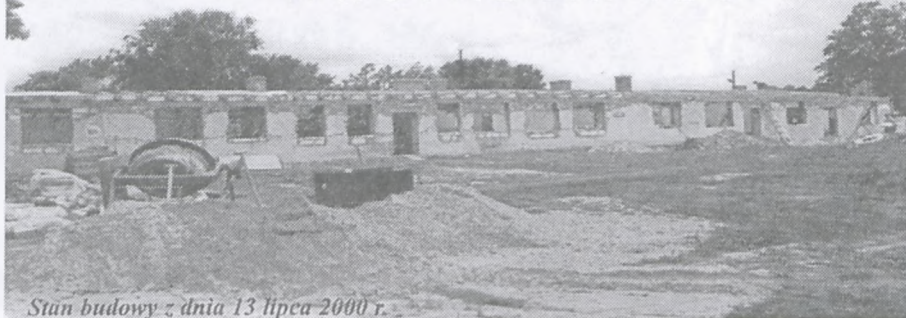
Stan budowy z dnia 13 lipca 2000 r.
