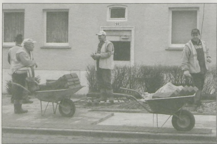
- BUDOWA CHODNIKA na ulicy Poznańskiej już się rozpoczęła. Inwestycja realizowana jest w ramach porozumienia z GDDKiA
