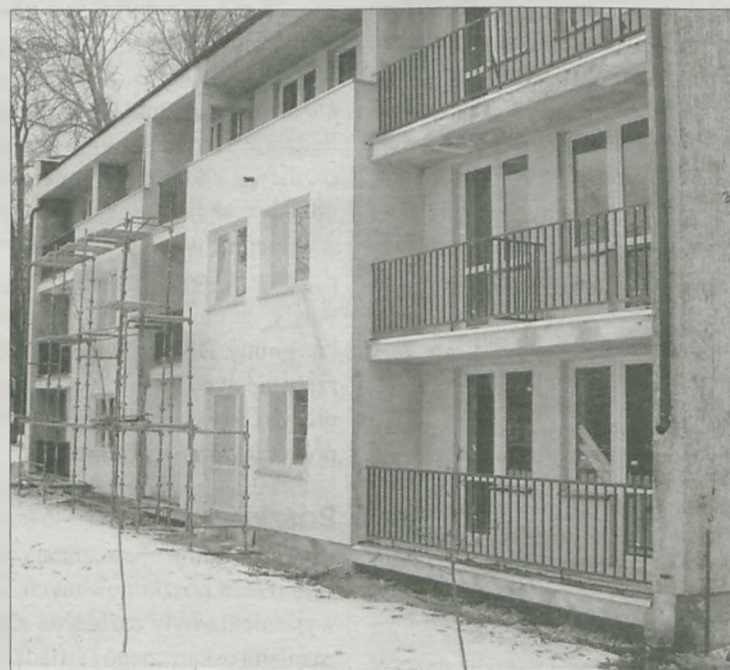
NA POTRZEBY Zakładu Aktywności Zawodowej „Promyk” adaptowany jest budynek mieszczący się w Żerkowie przy ulicy Jarocińskiej
