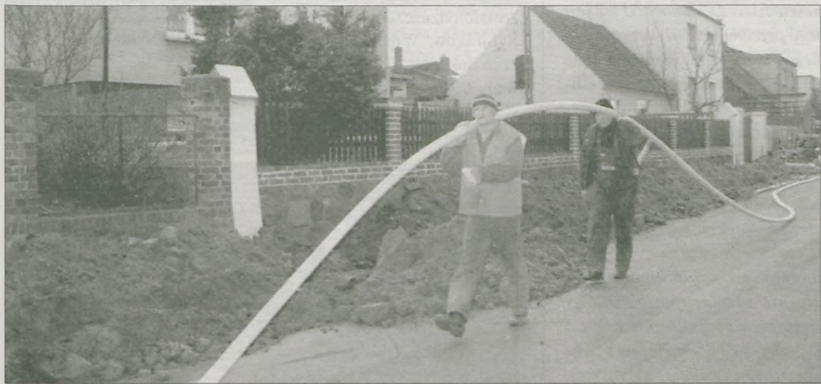
AKTUALNIE TRWA OSTATNI ETAP budowy gazociągu w Łobzie, Górze i Zalesiu.
