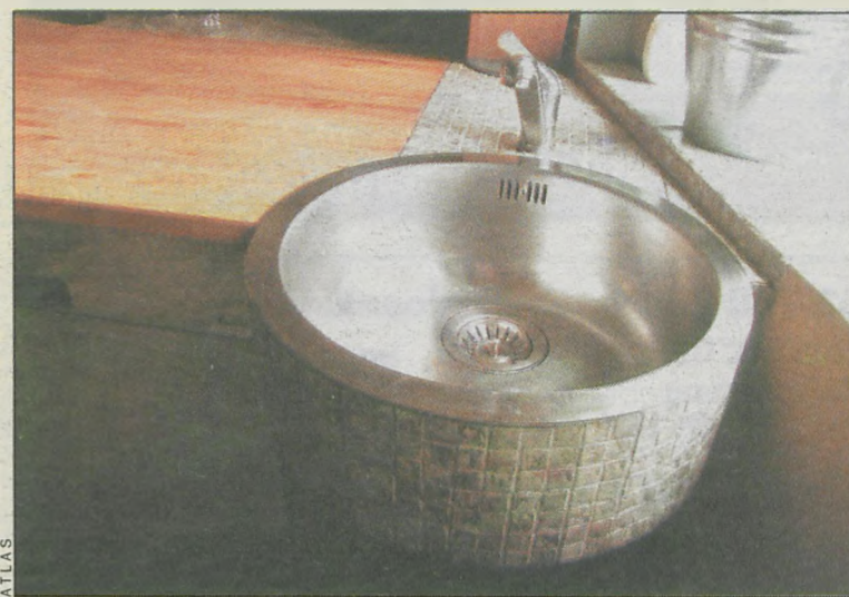
Zaletą mozaiki jest łatwość układania jej na łukach – na obudowach, filarach, itp.
