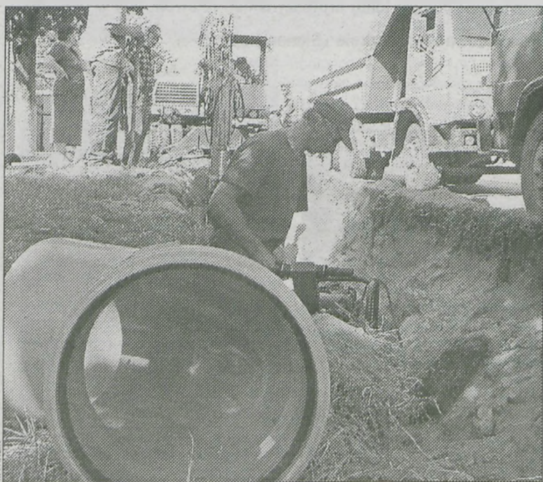
Prace na Błoniu utrudniają trochę ruch drogowy
