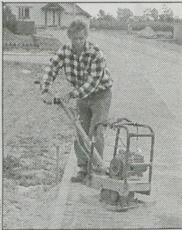
3 września będzie odbiór techniczny
