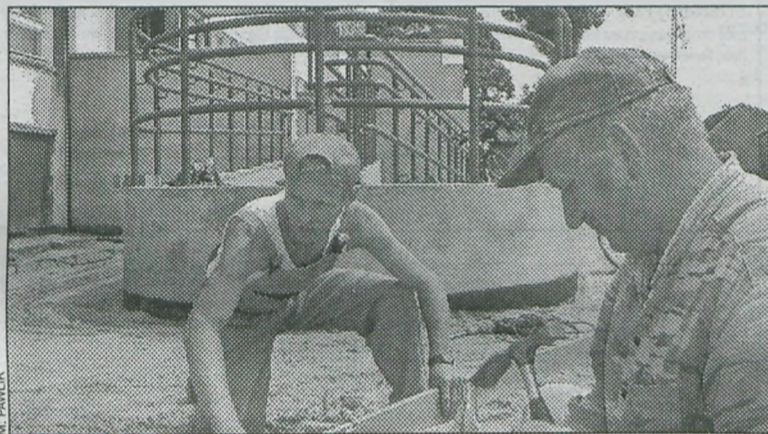
Schody będą gotowe jeszcze w lipcu
