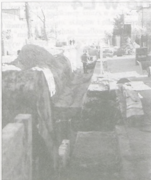
Kanalizacja ul. 11 Listopada. Jej budowę rozpoczęto we październiku
