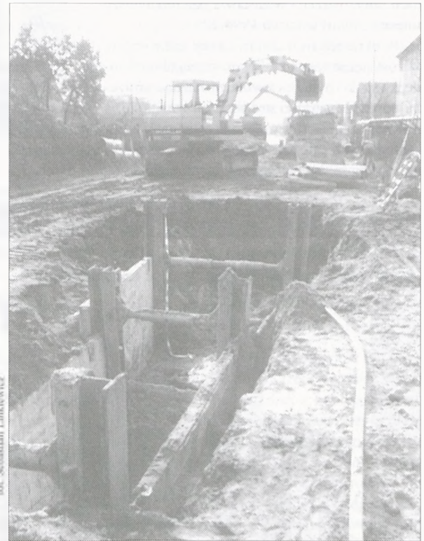
Budowa kanalizacji sanitarnej na ul. Szkolnej
