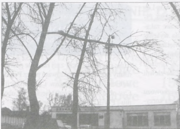
Gdyby nie przewody elektryczne, gałąź spadłaby może komuś na głowę
