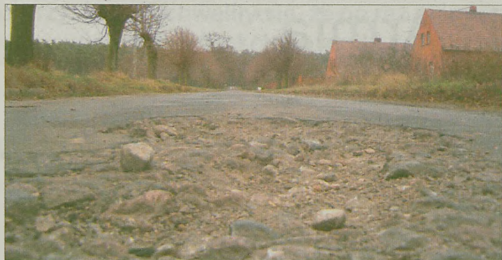
NAPRAWA DROGI POWIATOWEJ z Radlińca do Klęki ma kosztować blisko ćwierć miliona złotych
