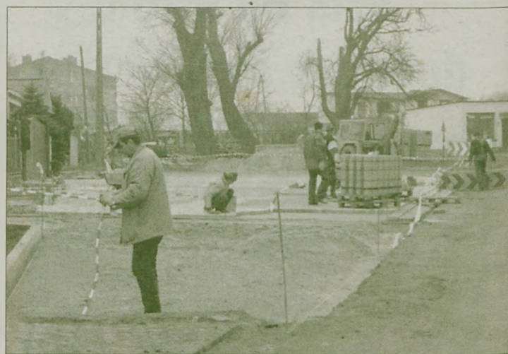
KOSTKĘ BRUKOWĄ wyłożono plac przy ul. Kościńskiej w Noskowie
