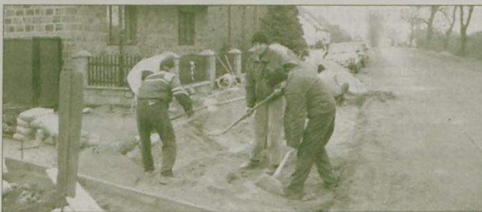
W GOLI rozpoczęła się budowa chodnika
