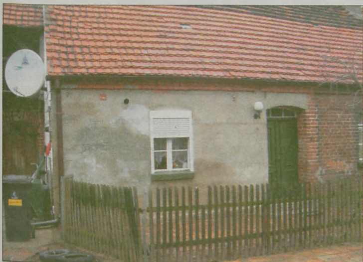
JESZCZE PRZED ŚWIĘTAMI rodzina Górnych zamieszka w tym budynku w Żółkowie
