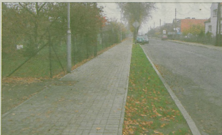
CHODNIK przy ulicy Żerkowskiej w Jarocinie na odcinku od ul. Sportowej do Harcerskiej został wyremontowany
