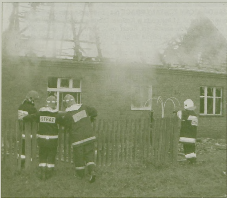
WYPALONY BUDYNEK nadaje się jedynie do zburzenia
