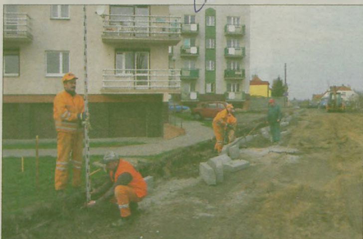
BĘDZIE NOWA NAWIERZCHNIA na ul. Bema w Jarocinie oraz parking dla samochodów
