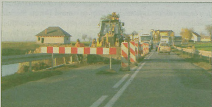
W ŁOBSIE budowany jest przepust. Na drodze krajowej nr 12 występują utrudnienia
