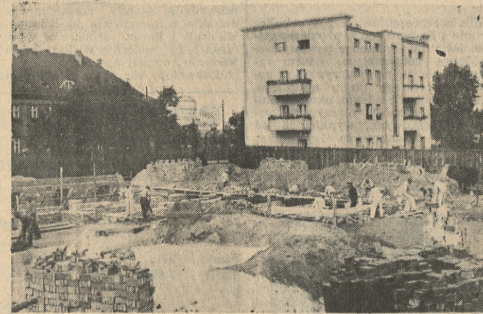
Obecny stan robót przy budowie wytwórni protez przy Przemysłowej 24-25
