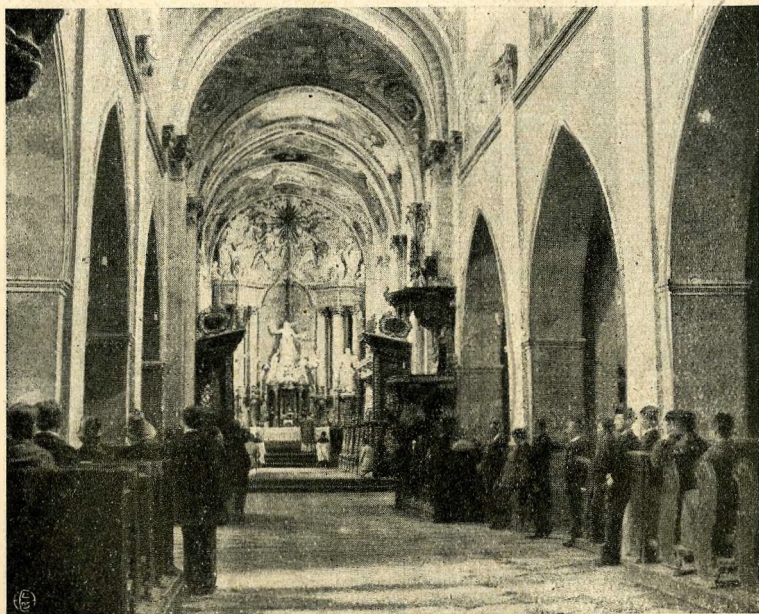
Ryc. 56. Wnętrze kościoła poklasztornego w Jędrzejowie.
