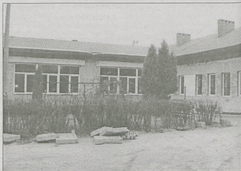
Rozbudowa Szkoły Podstawowej w Żukach jest na ukończeniu
