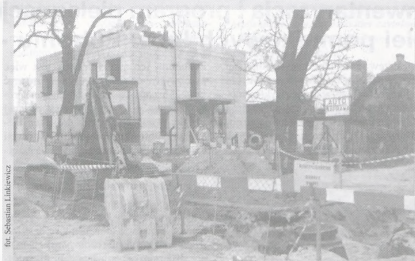
Trwają prace kanalizacyjne na ul. Lipowej. Tym samym kończy się etap kanalizacji miasta zaplanowany na rok 1996. (H.S.)
