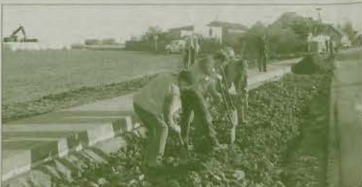
ZATOKA AUTOBUSOWA jest budowana przy drodze krajowej nr 12 w Łobzie
