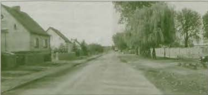
ULICA DWORCOWA w Golinie zostanie przebudowana dopiero w 2005 r.
