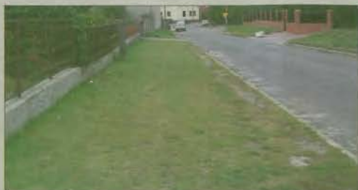
MIESZKAŃCY UL. GLINKI W JAROCINIE już niebawem będą mieli nowy chodnik. Obecnie prowadzone są prace na ul. Długiej Pracownicy spółki „Kanbud” układają tam kostkę brukową na długości 153 metrów. Pochłonie to 96 tys. zł
