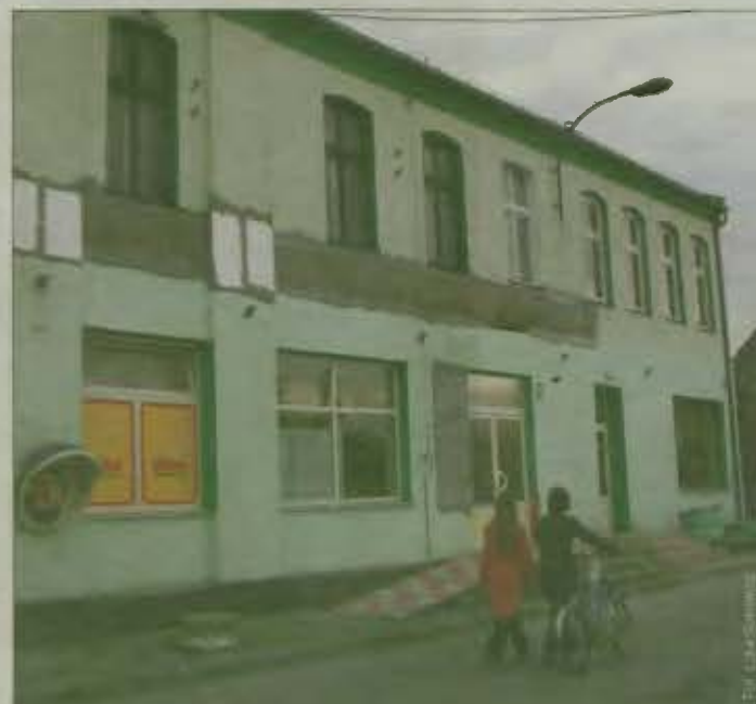
NA POTRZEBY supermarketu został zaadaptowany parter budynku
