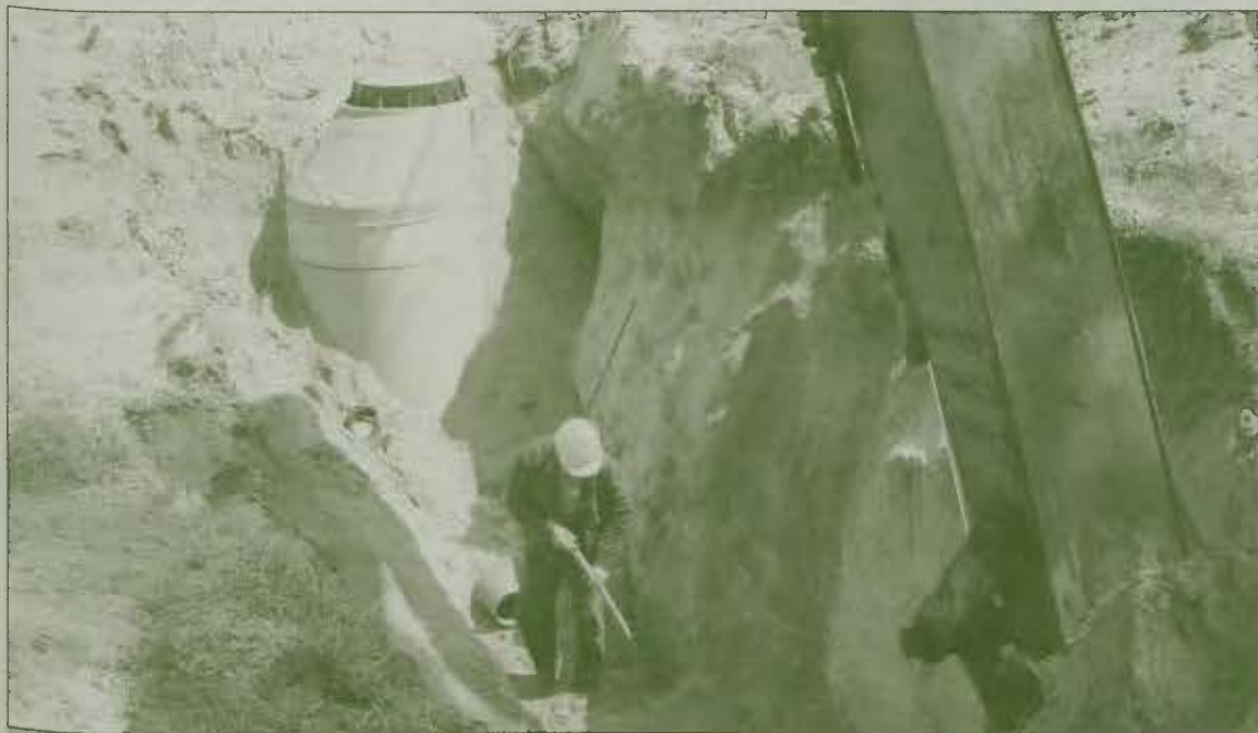
JESZCZE NIE WIADOMO ile mieszkańcy gminy Jaraczewo będą płacili za ścieki i za przyłączenie do kanalizacji. Negocjacje w tej sprawie z władzami gminy Jarocin cały czas trwają, podobnie jak budowa sieci kanalizacyjnej na terenie gminy Jaraczewo
