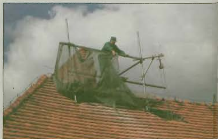
PRACE REMONTOWE na dachu szkoły w Komorzu
