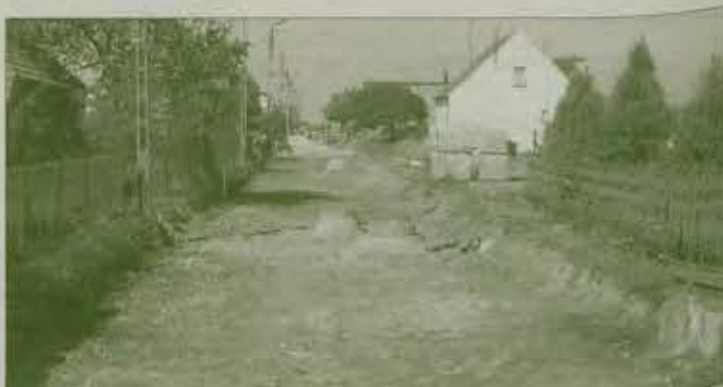
NA ULICY NOWE PARCELE w Jarocinie prowadzono prace kanalizacyjne. Do końca września ma zakończyć się układanie nowej nawierzchni na drodze.
