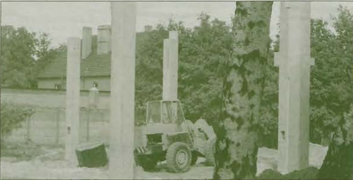
NA MIEJSCU wyburzonej fabryki obrabiarek już powstaje konstrukcja nowego, kolejnego supermarketu w Jarocinie
