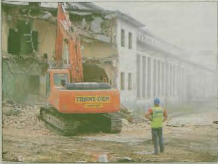
W Ubiegłym tygodniu robotnicy rozpoczęli wyburzenie biurowca
