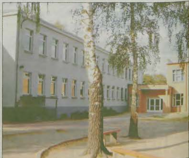
W SZKOLE PODSTAWOWEJ w Chociczy przeprowadzony zostanie remont dachu
