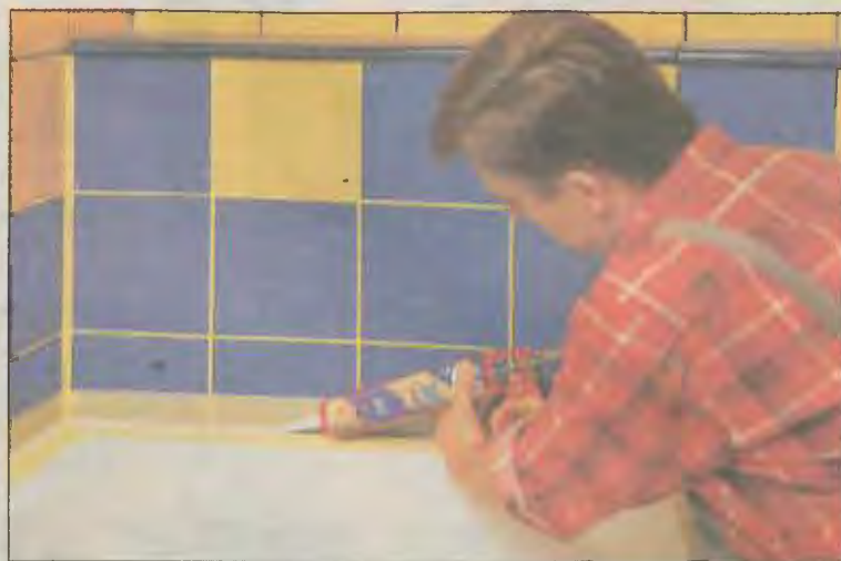
PRZED NANIESIENIEM SILIKONU naklejamy samoprzylepną taśmę malarską. W ten sposób otrzymamy równą i elastyczną linię oraz zmniejszamy ryzyko zabrudzenia powierzchni silikonem, który potem trudno usunąć
