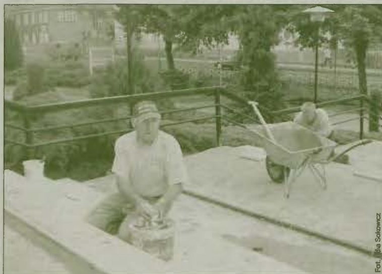
KAZIMIERZ RZEPCZYK, którego firma remontuje schody prowadzące do franciszkańskiej świątyni, kilkadziesiąt lat wcześniej pracował przy budowie kościoła
